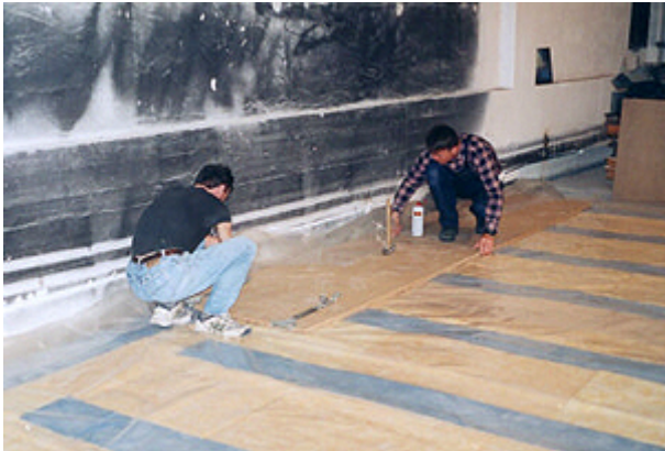
Verlegung einer 19 mm dicken Spanplatte als verlorene Schalung
