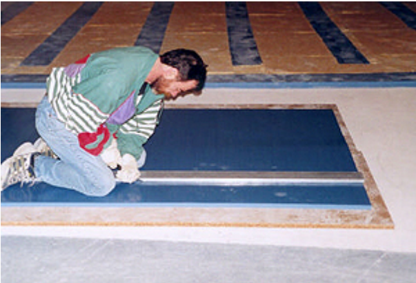
Zuschneiden der Sylomer®-Lagerstreifen
