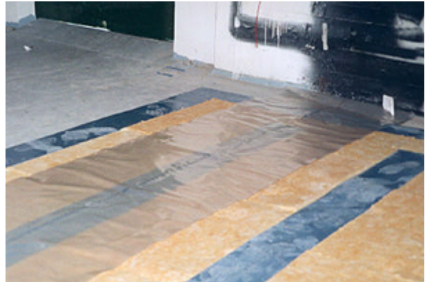
Ausfüllen der Zwischenräume
