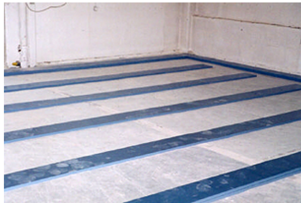
Positionierung der Sylomer®-Lagerstreifen auf dem Hallenboden.
