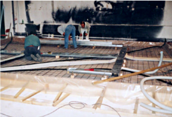
Die Bewehrung sowie die vorgesehenen Kabelkanäle und Leerrohre werden wie üblich montiert.
