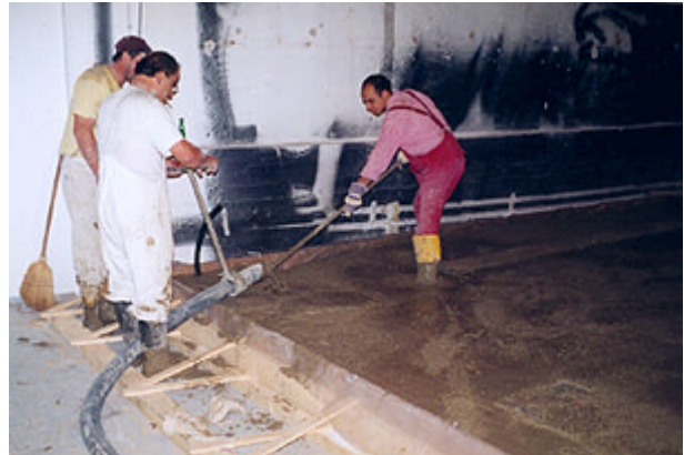
Betonieren der Bodenplatte: Die Bodenplatte wird herkömmlich betoniert
