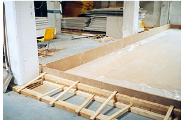
Aufstellen der seitlichen Schalung für die Bodenplatte.
